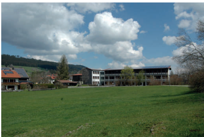
Kindergarten und Schule mit PV-Anlagen
