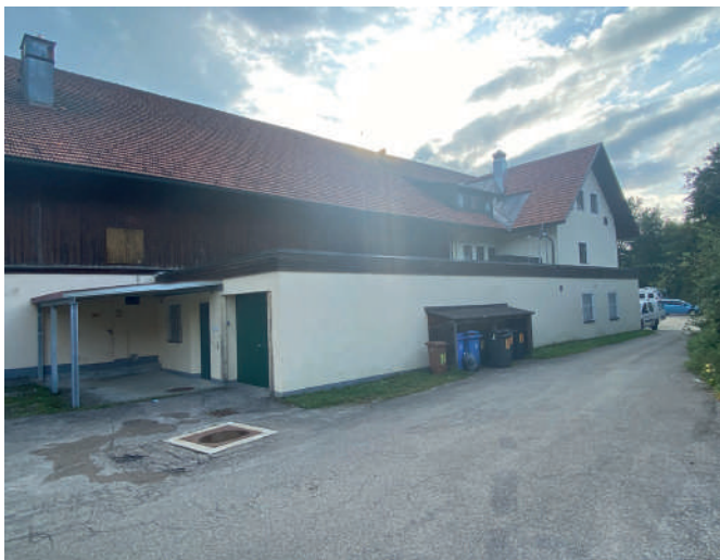
Unübersichtliche Anbauten im Norden des Gebäudes
